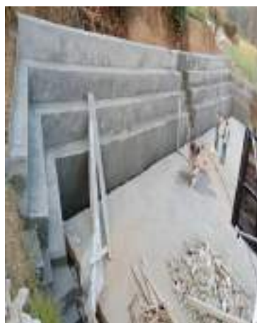
गामको प्याराफिट निर्माण कार्य
